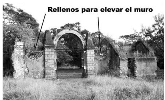
Fig. 5. Elevación del muro mediante el relleno de los arcos invertidos a ambos lados de la entrada
