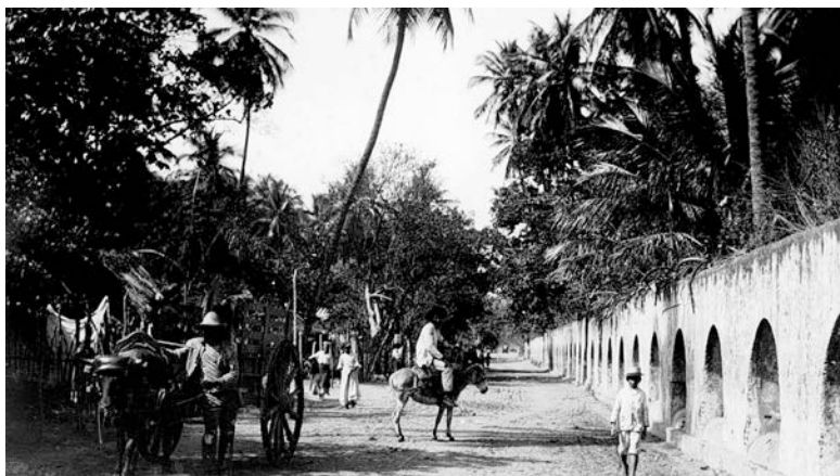
Fig. 5. Imagen de principios del siglo xx, donde puede observarse aún el buen estado constructivo del acueducto La Noria.
