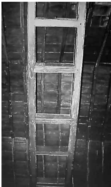
Fig. 21. Techo de armadura original de la nave de la iglesia de par e hilera con tirante doble sin decoración. Trinidad.
