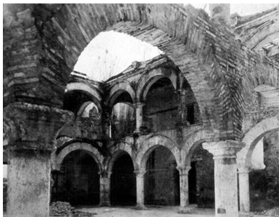
Fig. 12. La Popa. Estado ruinoso del claustro del convento. Cartagena de Indias.
