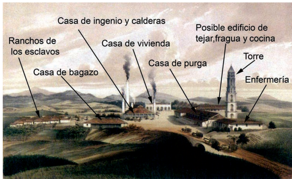
Fig. 9. Ingenio Manaca-Iznaga. Componentes de su estructura fabril. Grabado del libro de Los ingenios , 1857.
