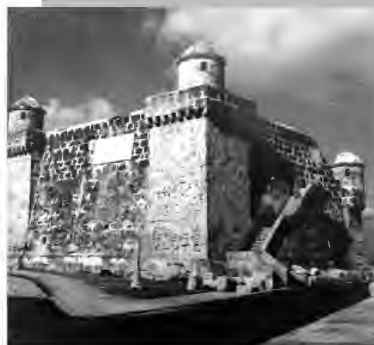
Foto del reducto en los años 1923 y 1952, donde se aprecia el cambio en la fisonomía de la escalera de acceso. Fondo: Colección Pérez Beato
