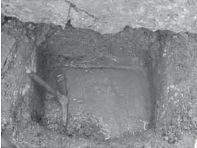
Figura 5. Cañería cuyos muros están labrados en la roca estructural ubicada en el subsuelo de la calle Obispo.
