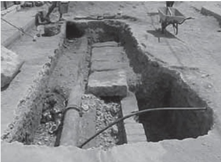
Figura 4. Cañería de ladrillos cubierta con sillares de roca caliza ubicada en el subsuelo de la calle Amargura entre San Ignacio y Mercaderes.
