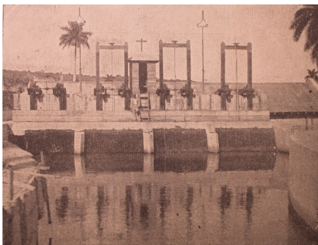
FIG. 2. Entrada de agua a las turbinas ubicadas en la casa de máquinas. Fuente: Magazine La Lucha
