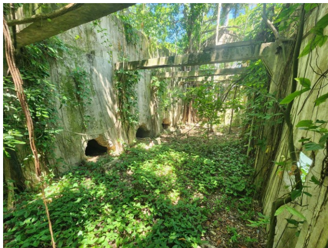
FIG. 6. Cuarto de maquinas donde se observan las bases de los alternadores ilustrados en la figura 3 y los agujeros de las turbinas. Foto: OHL
