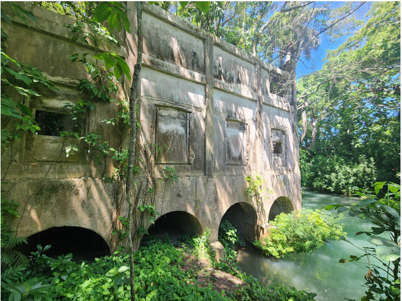
FIG. 7. Vista del edificio donde se observan los espacios abovedados por donde el agua solía reincorporarse al cauce del río. También se observan las aberturas tapiadas del cuarto de máquinas. Foto: OHL
