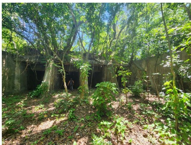
FIG. 5. Vista actual de la entrada de agua a la casa de máquinas. Foto: OHL
