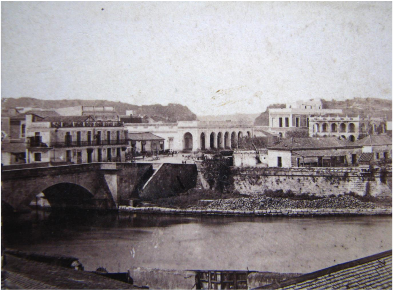
FIG. 4. Detalle de una de las esterovistas tomadas por George N. Barnard en 1860, Matanzas. Esta vista proporciona detalles del puente de Bailen, la antigua batería de La Vigía y actividad en la plaza homónima. Nótese el grado de deterioro de la batería, a la cual le crece vegetación en sus muros, y yacen escombros en su base. Nótese también la ausencia de la Ermita de Monserrate en la Loma del Estero, en última plana
