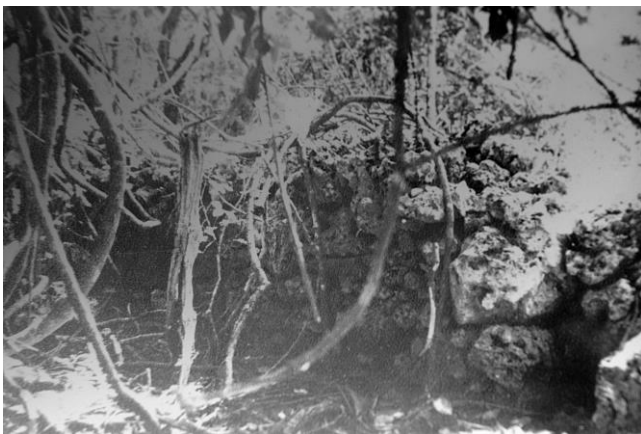
FIG. 6. Restos de muros de uno de los fortines
