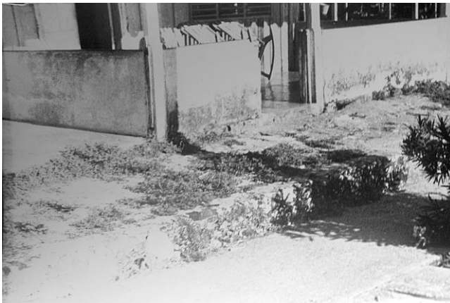
FIG. 4. Cimientos y piso del fortín de La Grifa
