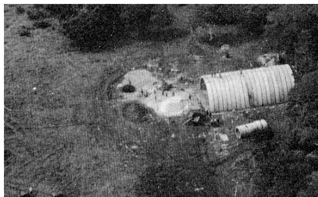
FIG. 3. Imagen del hangar, reconocimiento de EE.UU. en 1962
