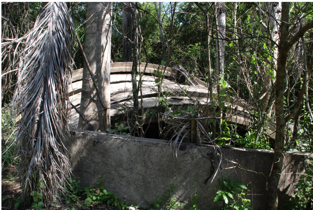
FIG. 6. Imagen del hangar caído
