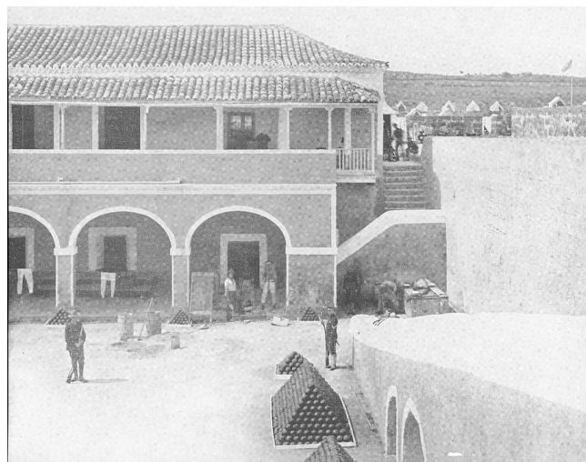
FIG. 2B. Vista interior del patio central o plaza de armas del Castillo de San Severino durante la Guerra Hispano-Cubano-Americana, donde se observan parcialmente las bovedillas y la rampa en 1898-1899
