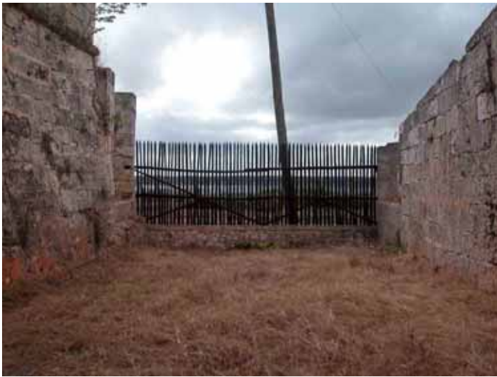
FIGURA 7. Área de trabajo antes de la intervención
