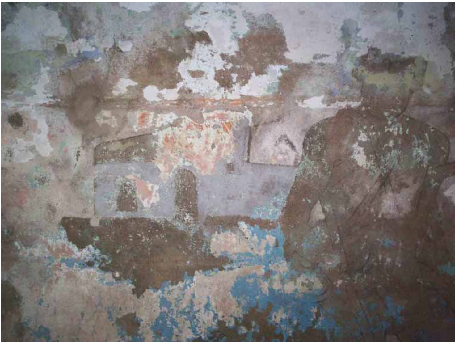
FIGURA 2. Detalle de la edificación
