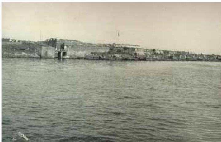
FIGURA 2. Vista donde se observa el puente (1901)
