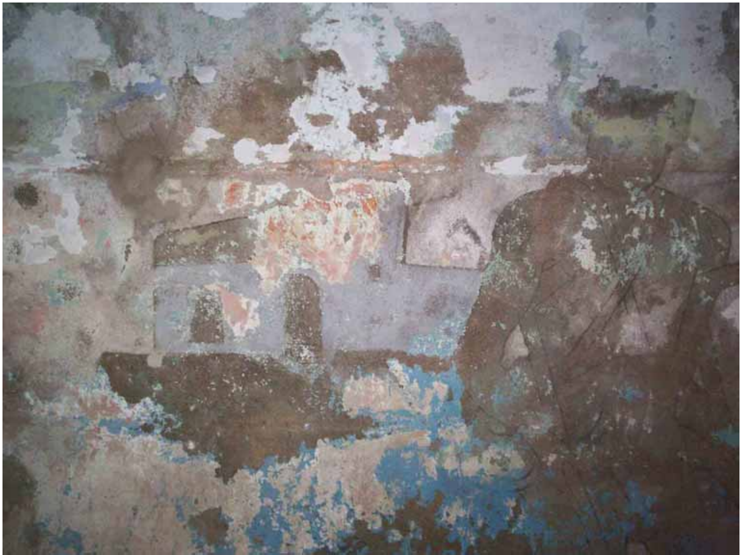
FIGURA 2. Detalle de la edificación
