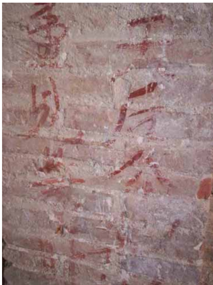
FIGURA 4. Vista de los ideogramas chinos sobre los muros de ladrillo
