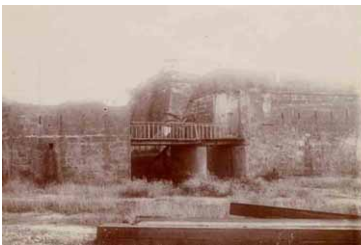
FIGURA 3. Vista del puente (década del cuarenta, siglo XX)
