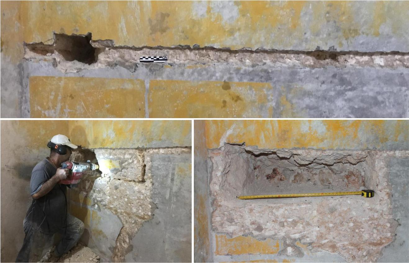
**FIG. 3.** Cala parietal y expansión en el extremo izquierdo. Se observa la exposición de sillares del muro y la presencia de relleno detrás
