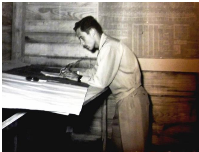
FIG. 3. Rivero trabajando en la construcción de carreteras
