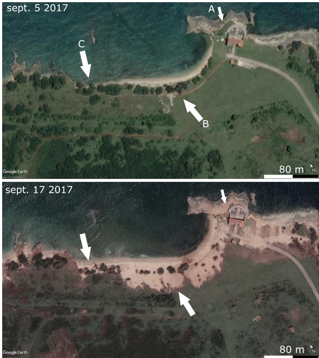
Fig. 2. Imágenes satelitales del litoral y batería de El Morrillo tomadas antes y después de paso del huracán Irma. Las flechas indican algunas de las áreas de mayor impacto erosivo-natural. A. duna que yacía entre el muro de barbata y los cimientos del antiguo torreón. B. extensión del transporte de sedimentos y denudación por detrás de la antigua duna de tormenta. Nótese el desplazamiento de arena a más de 20 metros de la duna antigua. C. pérdida litológica y denudación del frente y escarpa de playa.
