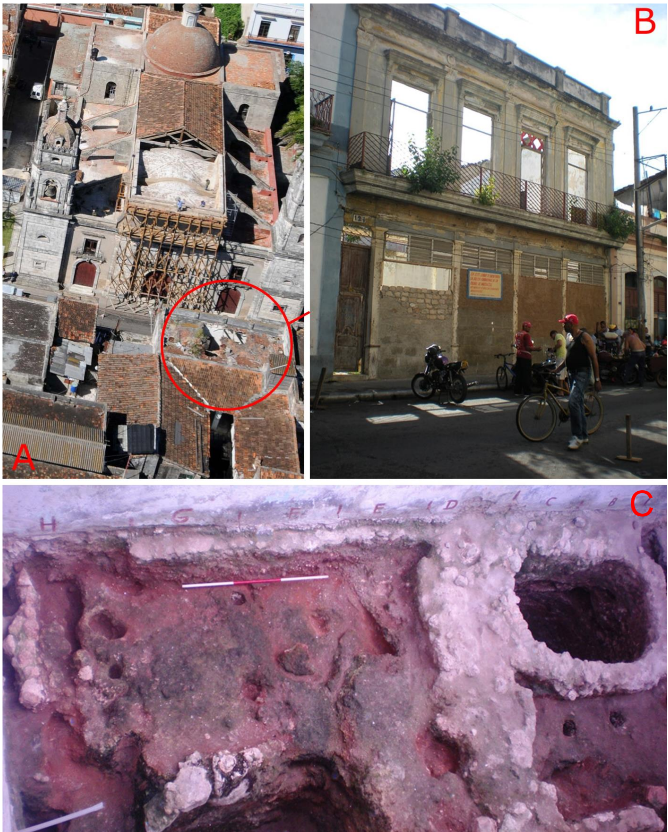
FIG. 1. (A) Localización de parte del área que ocupó la iglesia fundacional de Matanzas, frente a la actual Catedral de San Carlos de Borromeo, ciudad de Matanzas, Cuba. (B) muestra la fachada actual del lote J10-J12. (C) vista de la excavación que revela huellas de poste y pozo con brocal. En la esquina superior izquierda se puede ver un fragmento de un antiguo muro de la iglesia fundacional
