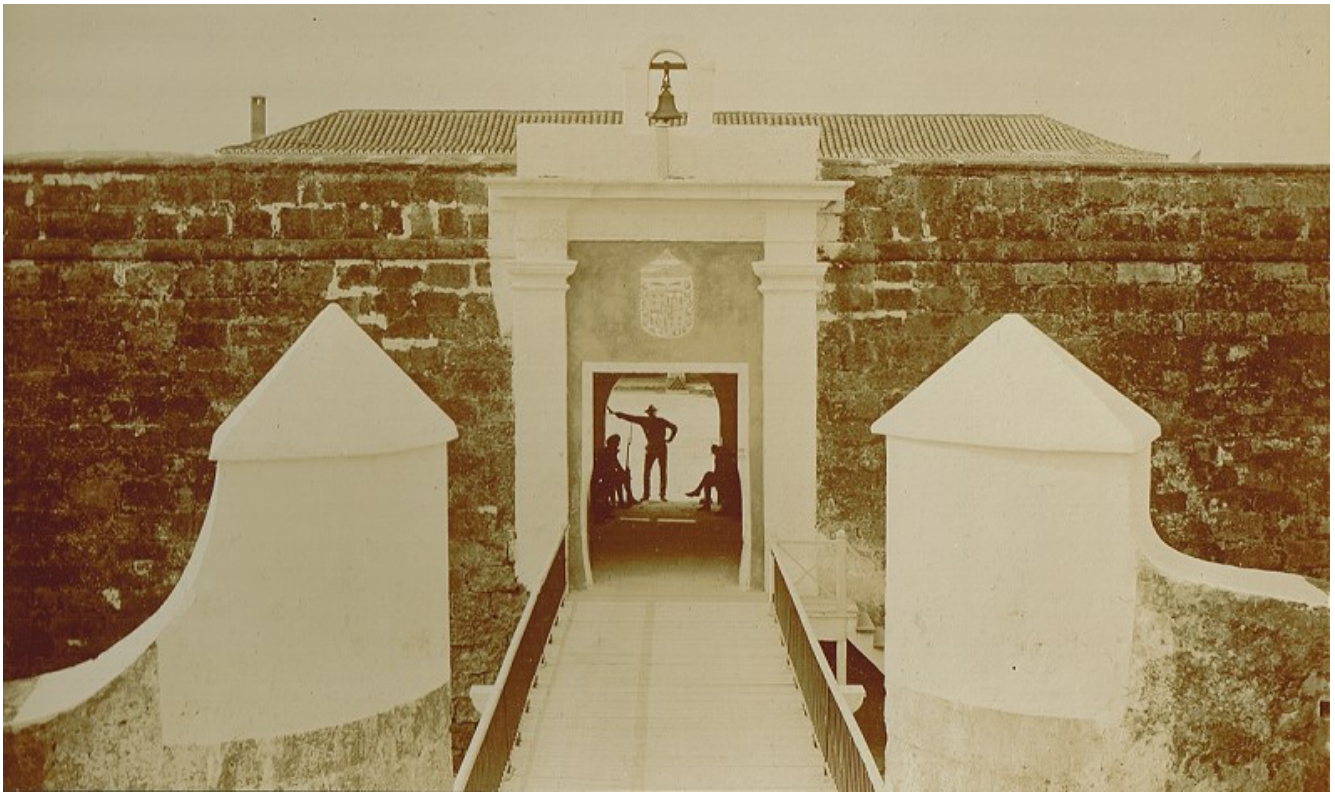
FIG. 1. Entrada del Castillo de San Severino hacia 1899 donde se observa el escudo de armas con una decoración en la parte superior. Foto cortesía Boris Rodríguez
