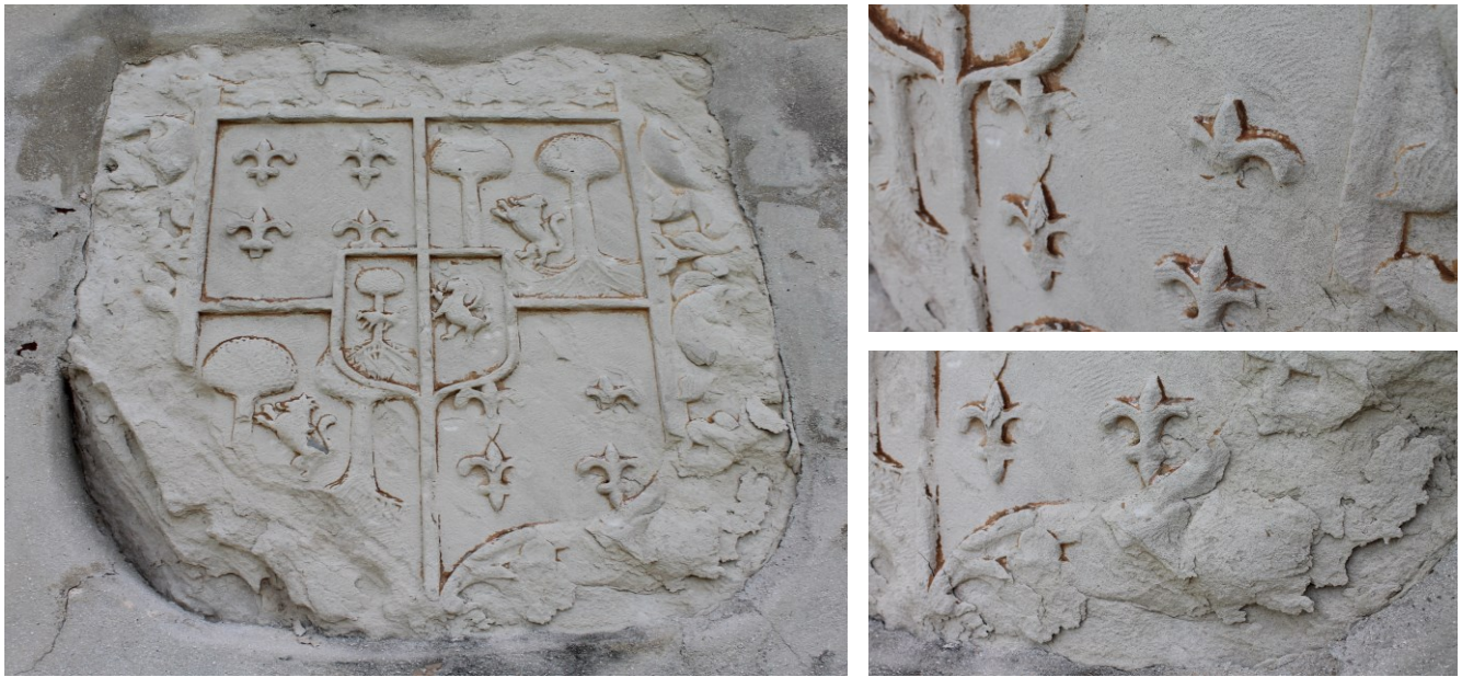
FIG. 6. El escudo del Castillo de San Severino (izquierda). Detalles del vértice inferior derecho donde se puede ver la exfoliación y descohesión en lascas de esta parte del escudo. Nótese los remanentes (¿oxidados?) de pintura en las esquinas. Nótese también la textura unidireccional que cubre todos los atributos de igual manera. Nótese el nivel de erosión de los lirios tallados. Fotos de Odlanyer Hernández de Lara (2017)
