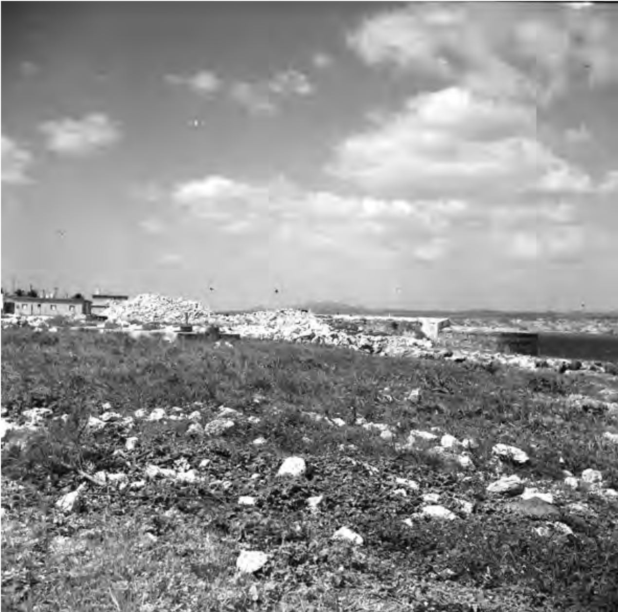
Figura 5.15. Fotografía del archivo del EMPAI, tomada después de su demolición en 1962. Archivo EMPAI.
