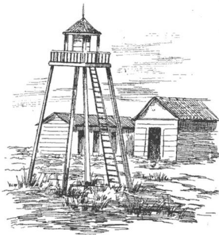
Figura 6.7. Torre y estructuras aledañas de tabla y teja de Los Prácticos (Revertér Delmas, 1897, p. 624).
