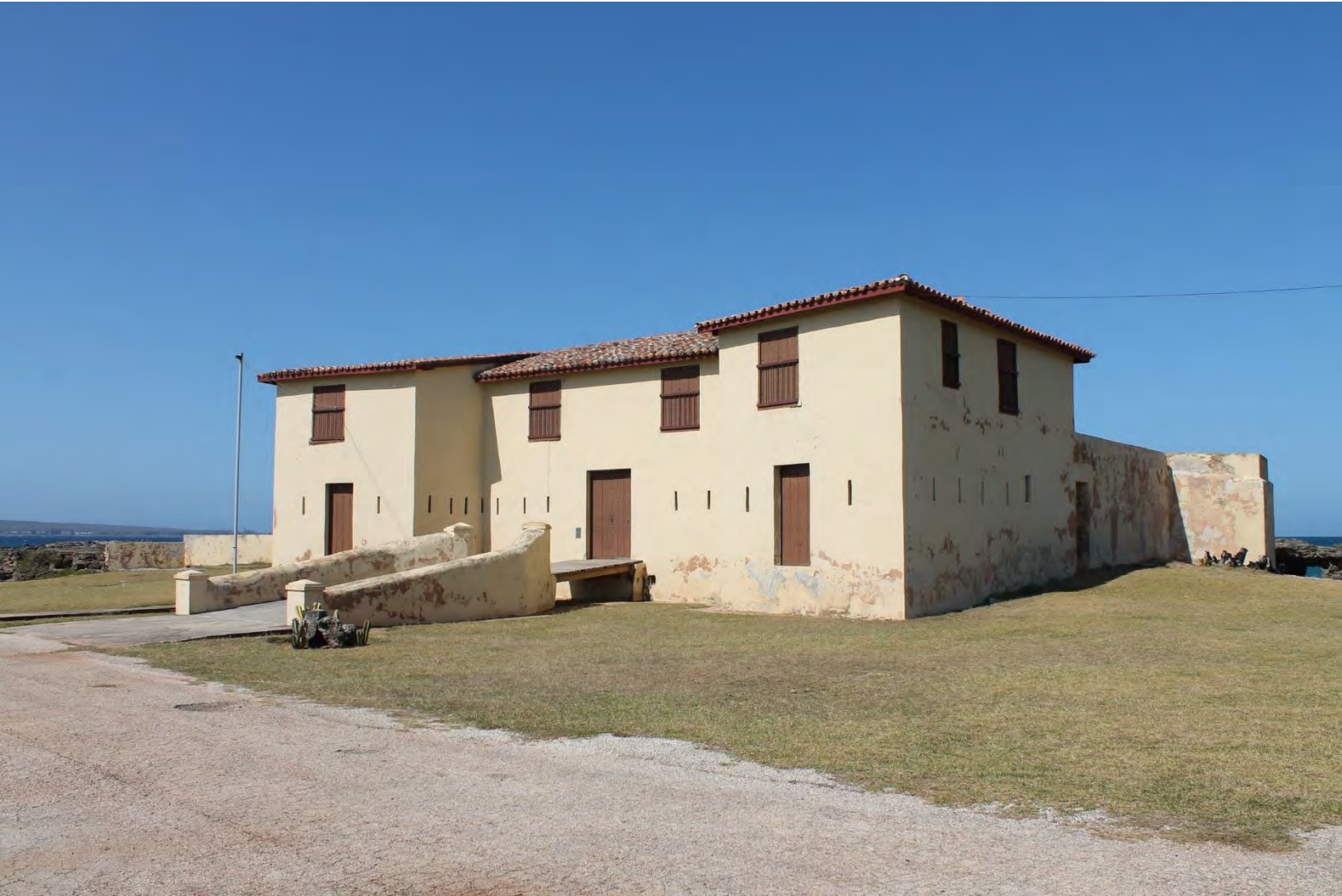
Bateria de San Felipe del Morrillo
