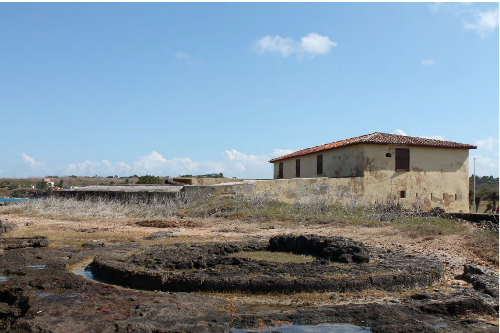
Figura 2.1. Vista de la base circular del Torreón de El Morrillo, con la batería detrás.
